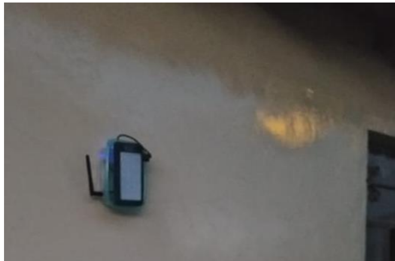
Figura 63. Instalación del nodo coordinador en la vivienda.
