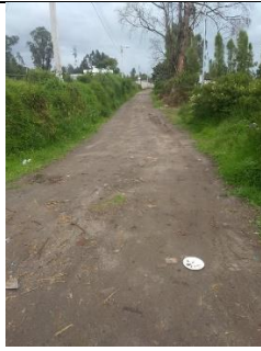
Calle Sta. Rosa
