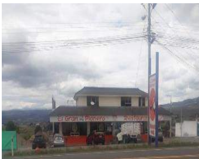
Figura 115. Lugar de estacionamiento.
