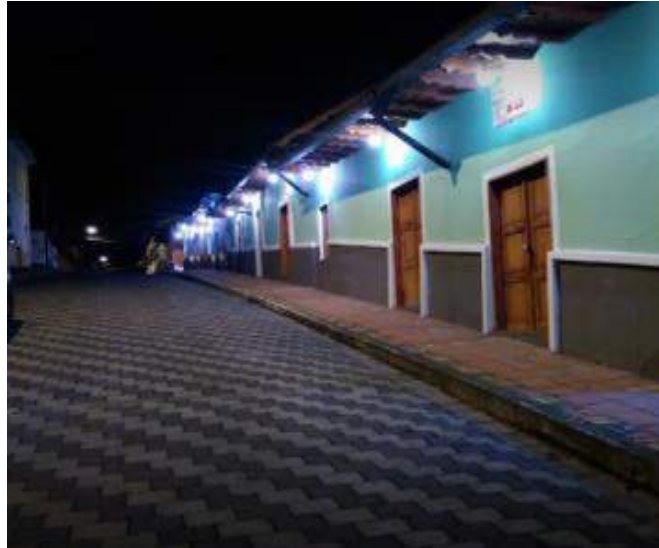
Figura 103. Acceso y puerta de ingreso.
