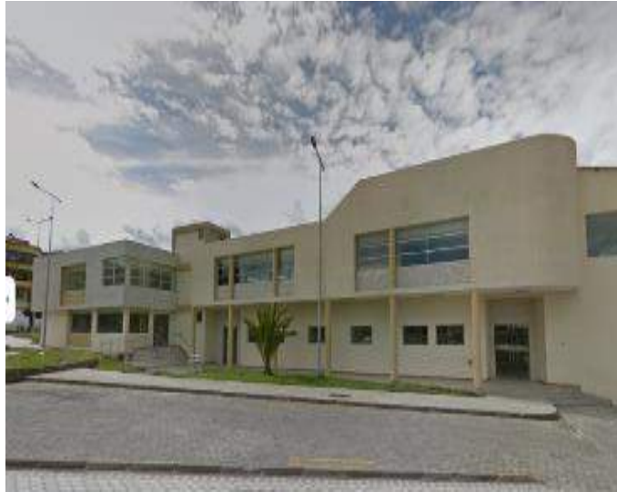
Figura 101. Lugar de estacionamiento
