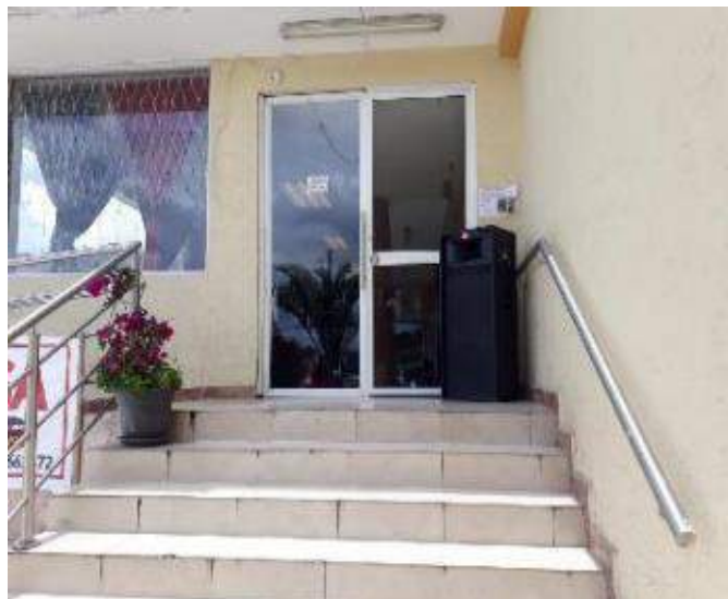
Figura 98. Puerta de ingreso y escaleras.
