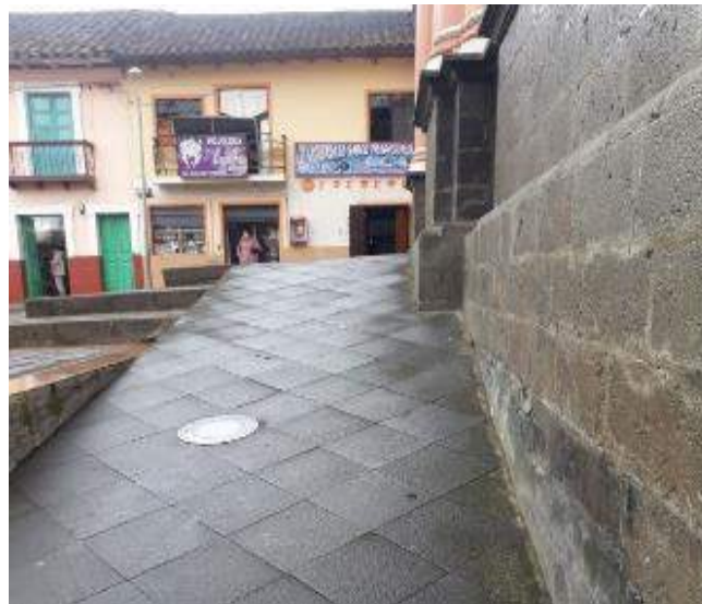
Figura 66. Rampas de ingreso (Iglesia Matriz).
