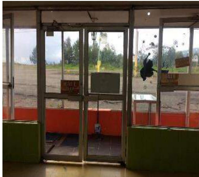
Figura 110. Acceso y puerta de ingreso.
