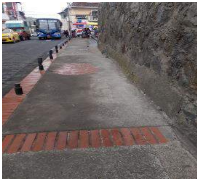
Figura 68. Vías de circulación (Iglesia Matriz).
