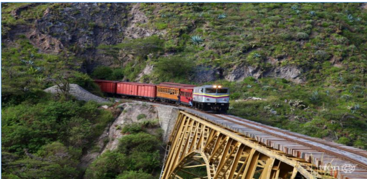
Figura 7. Tren rehabilitado en la vía Ibarra – Salinas Fuente: Empresa Pública Ferrocarriles del Ecuador
