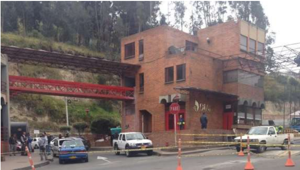
Ilustración 4. Edificación existente aduana Colombia Fuente: (Coronel, 2019)
