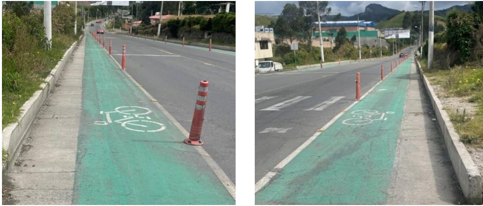
Figura 41. Ciclovía segregada del sector sur (obelisco) en la ciudad de Tulcán año 2021
