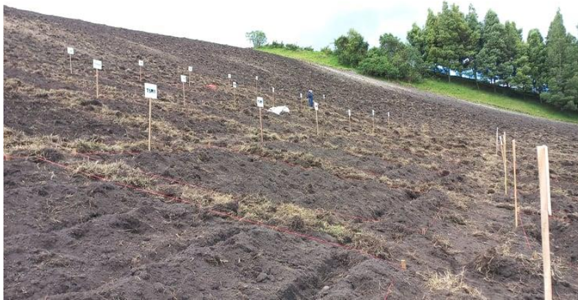
Anexo 11 Colocación de letreros
