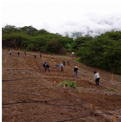
Figura 19. Adecuación del terreno
