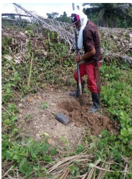
Figura 32. Preparación del terreno
