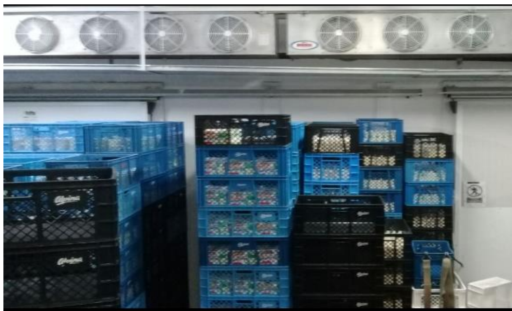
Figura 27: Instalaciones del almacén
