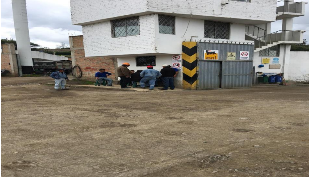
Centro de acopio REAL GAS S.A calles, Panamericana Norte y Av. Andrés Bello
