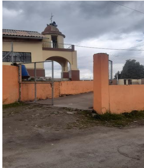
Figura 90. Comunidad de Casa Fría
