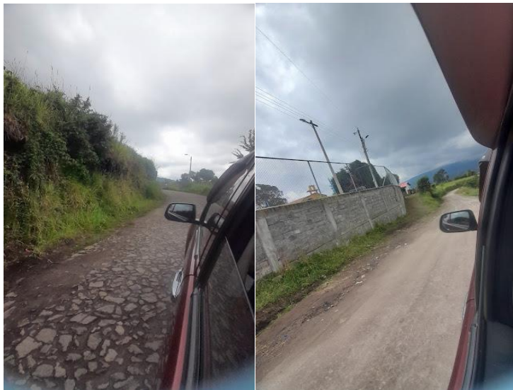
Figura 91. Infraestructura vial de Casa Fría
