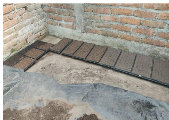
Figura 14. Colocación y distribución
