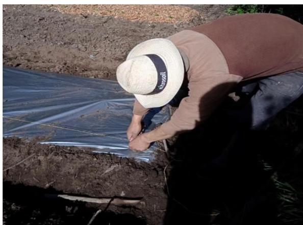
**Figura 7.** Instalación del mulch
