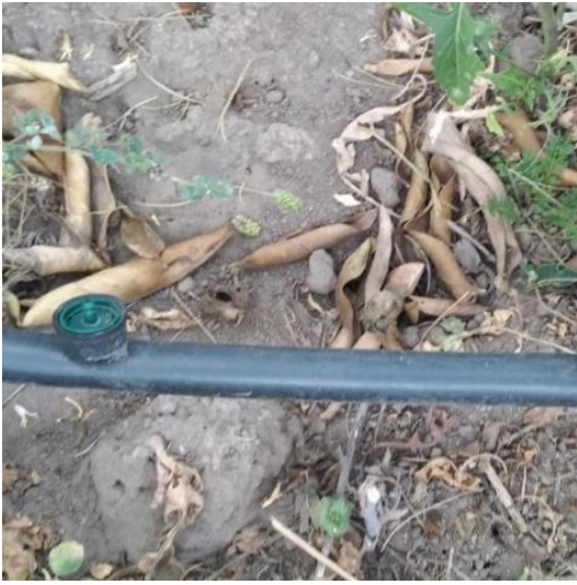
Figura 7. Gotero de caudal de 25lt/h
