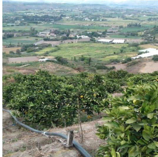
Figura 4. Tubería principal implementado en el sistema de riego.
