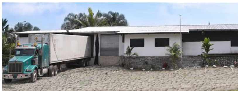
Figura 22. Planta empacadora de Malanga de Tropicalexpor S.A. Fuente: TROPICALEXPOR S.A (2022)
