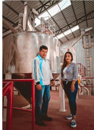
Visita al área de maquinarias
