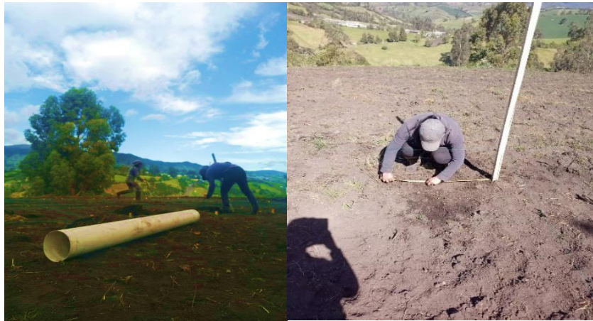
Figura 9. Preparación y delimitación del terreno
