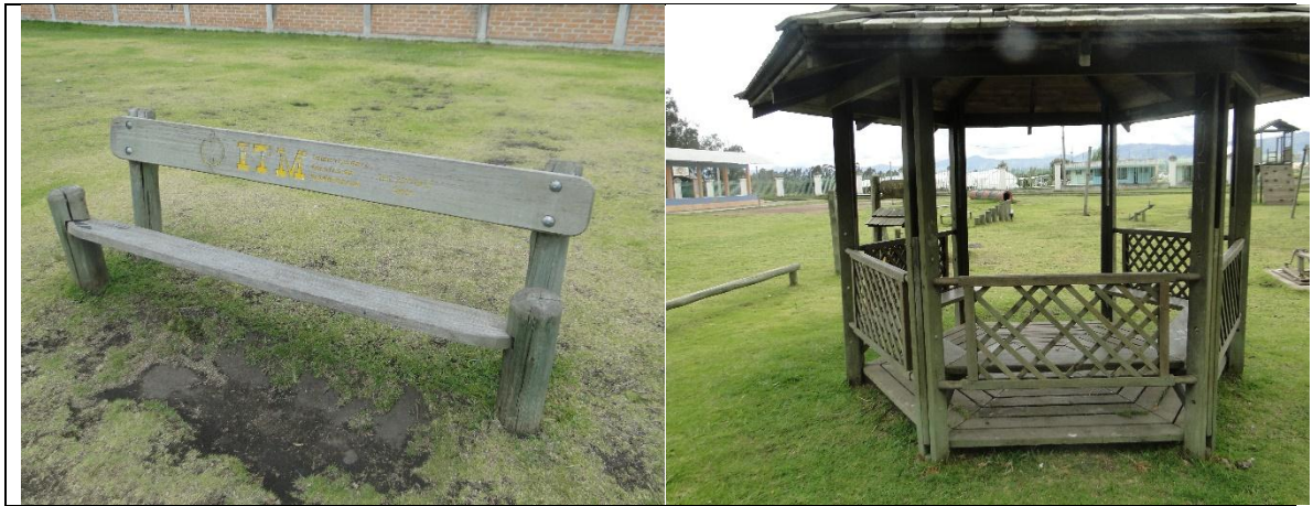
Anexo 17 : Equipamiento de descanso del complejo los Pastos
