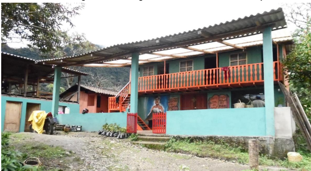
Fotografía 2 Albergue El Paraíso de Chilma Bajo
