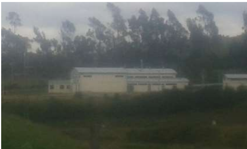
Figura 16. Foco de Insalubridad: Centro de Faenamiento
