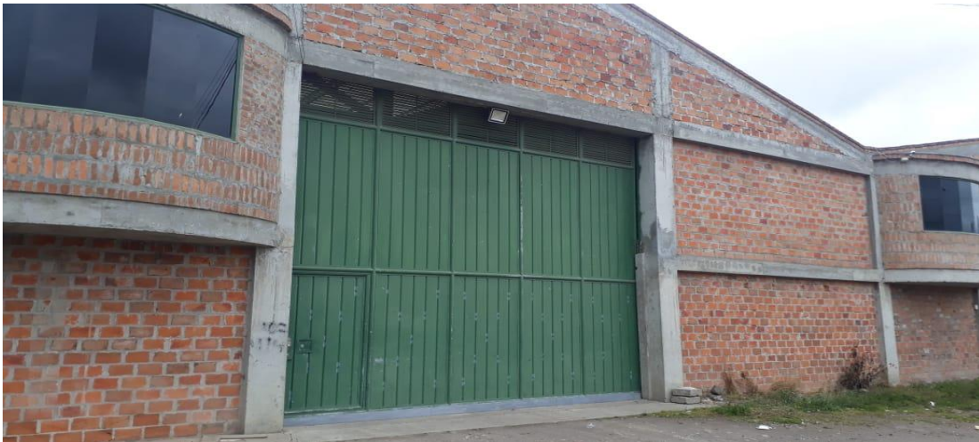
Figura 5. Bodega alterna de recepción 1
