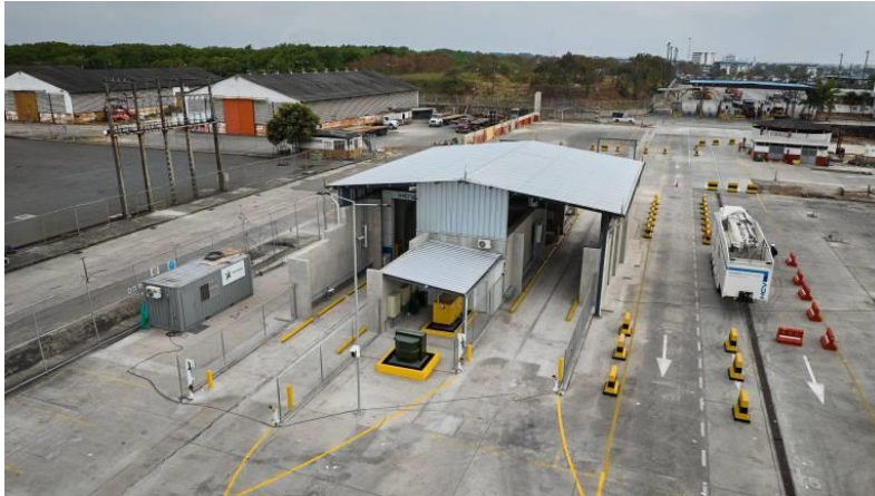
Ilustración 3. Escáneres en Instalaciones del Puerto CONTECON S.A., 2025
