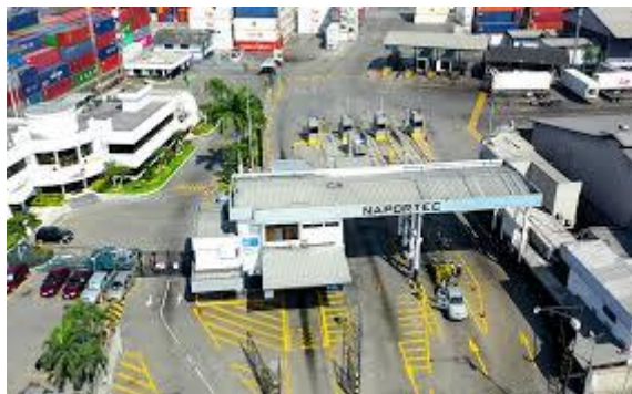
Ilustración 6. Escáneres en instalaciones del NAPORTEC S.A. / Bananapuerto
