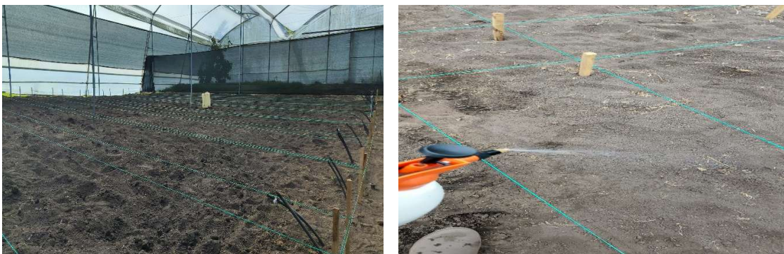
Figura 6. Preparación y desinfección del terreno
