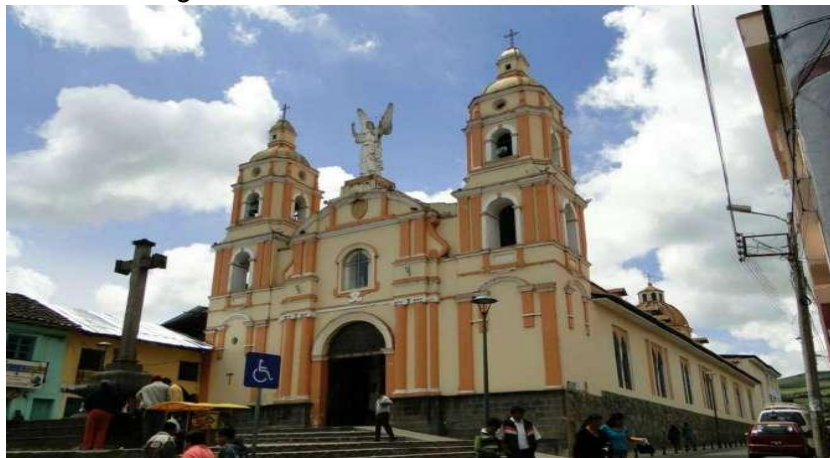
Fachada de iglesia Matriz
