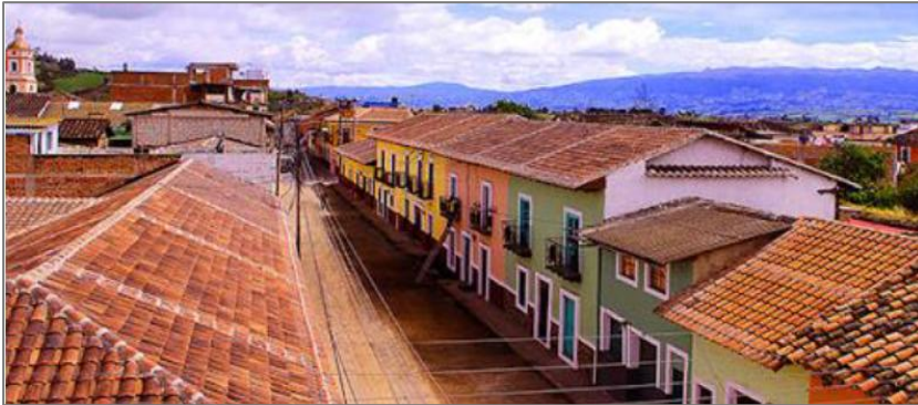
Cubiertas de inmuebles patrimoniales de calle Olmedo
