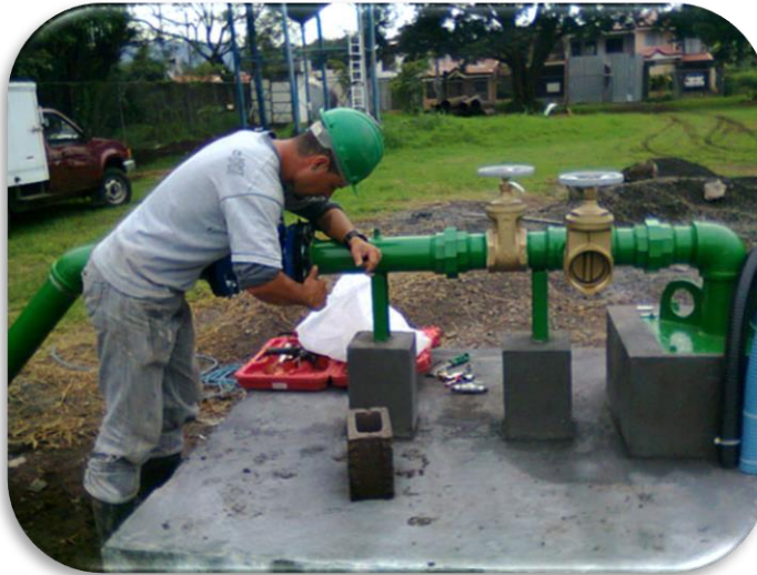
Gráfico 10.- Instalación de tuberías de agua potable.
