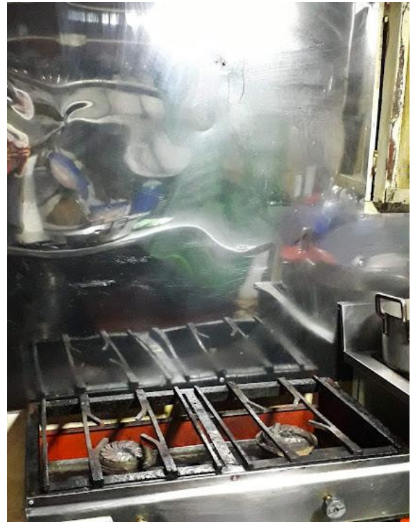
Figura 42. Después láminas protectoras en las paredes para facilitar su limpieza y desinfección.
