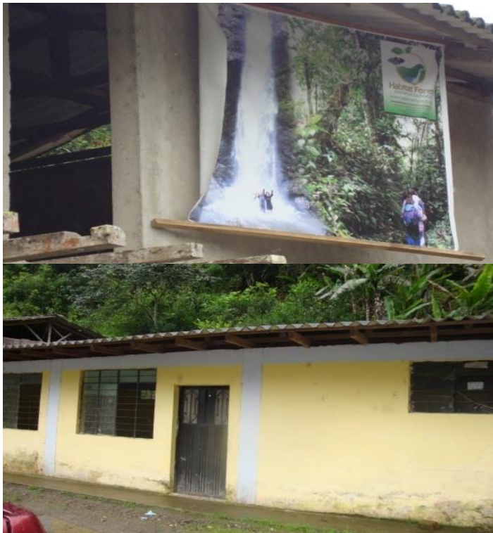
Tomada por: Paola Andrea Benavides Montenegro Salón comunal en donde se pretende construir albergue turístico.
