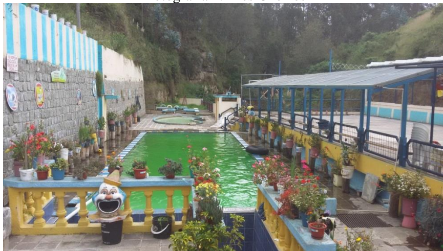
Piscina del Balneario Tres Chorros y parte de la infraestructura
