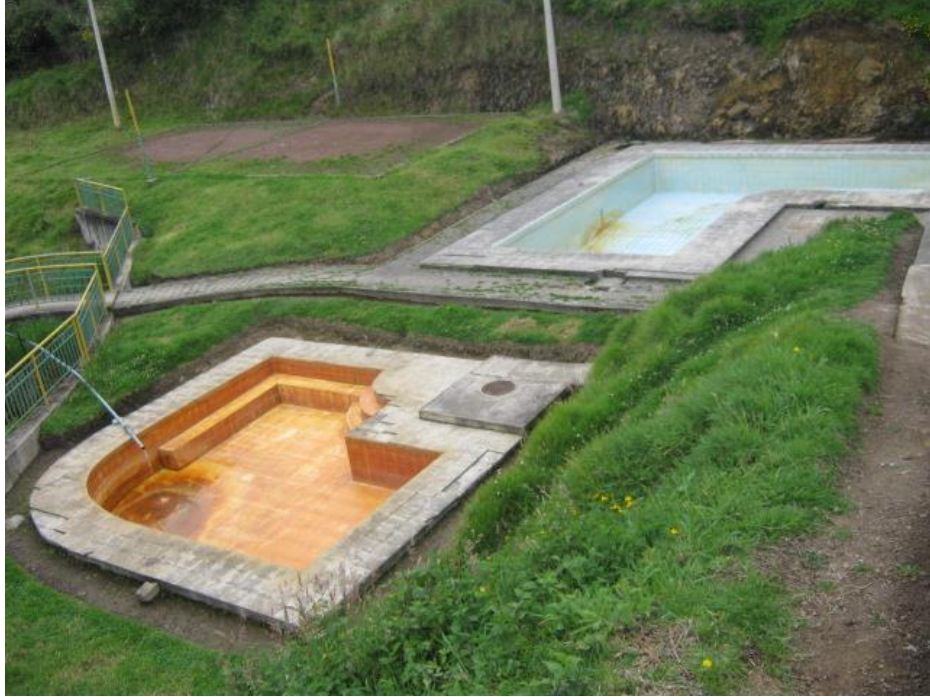
Vista de las piscinas vacías de Chabayán para darle el respectivo mantenimiento
