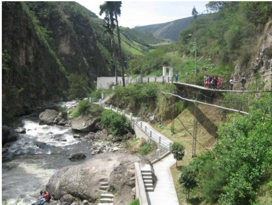
Puente colgante que conduce a las piscinas de agua termal, rodeado del río Apaquí
