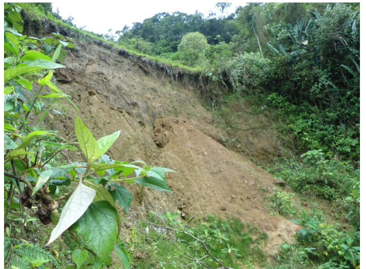
Mal estado del sendero
