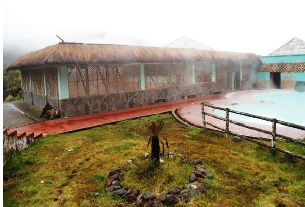
Vista frontal Complejo Tufiño (Aguas Hediondas)
