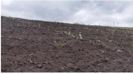
Figura 6. Preparación del terreno
