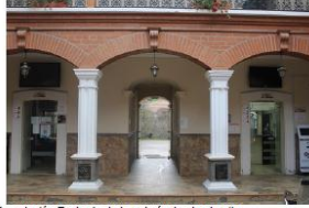
Descripción: Fachada de la galería desde el patio.
