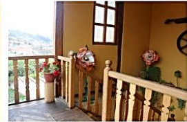
Descripción:Baranda de madera y parcial del desarrollo de la grada.
