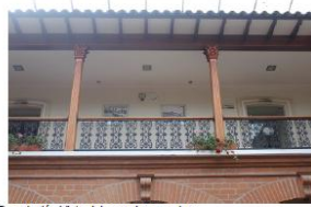
Descripción: Vista del corredor superior.
