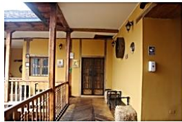
Descripción:Vista del corredor superior.
