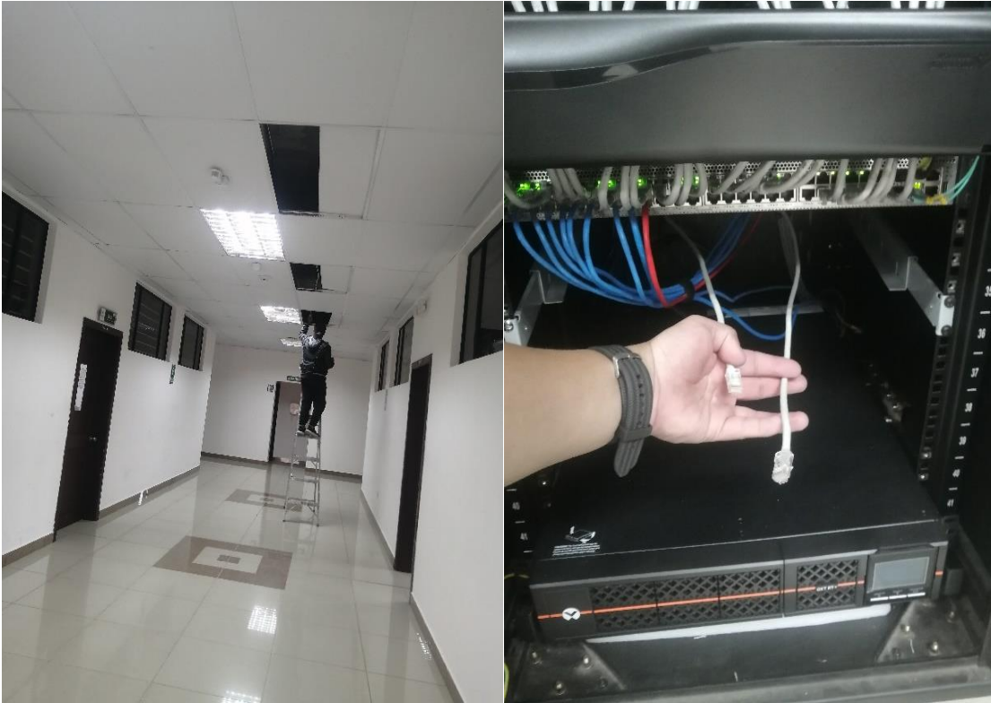
Figura 53: Cableado de red y ponchado
