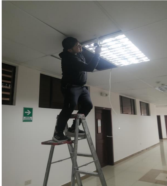
Figura 54: Conexión de cámara
