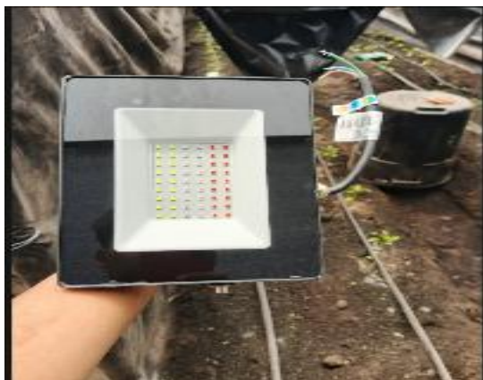
Figura 7. Instalación de reflectores LED
