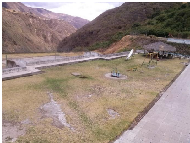
Ilustración 15 Juegos Infantiles Deteriorados
