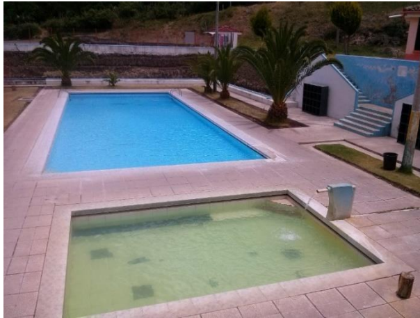
Ilustración 6 Piscinas de Agua Termal
