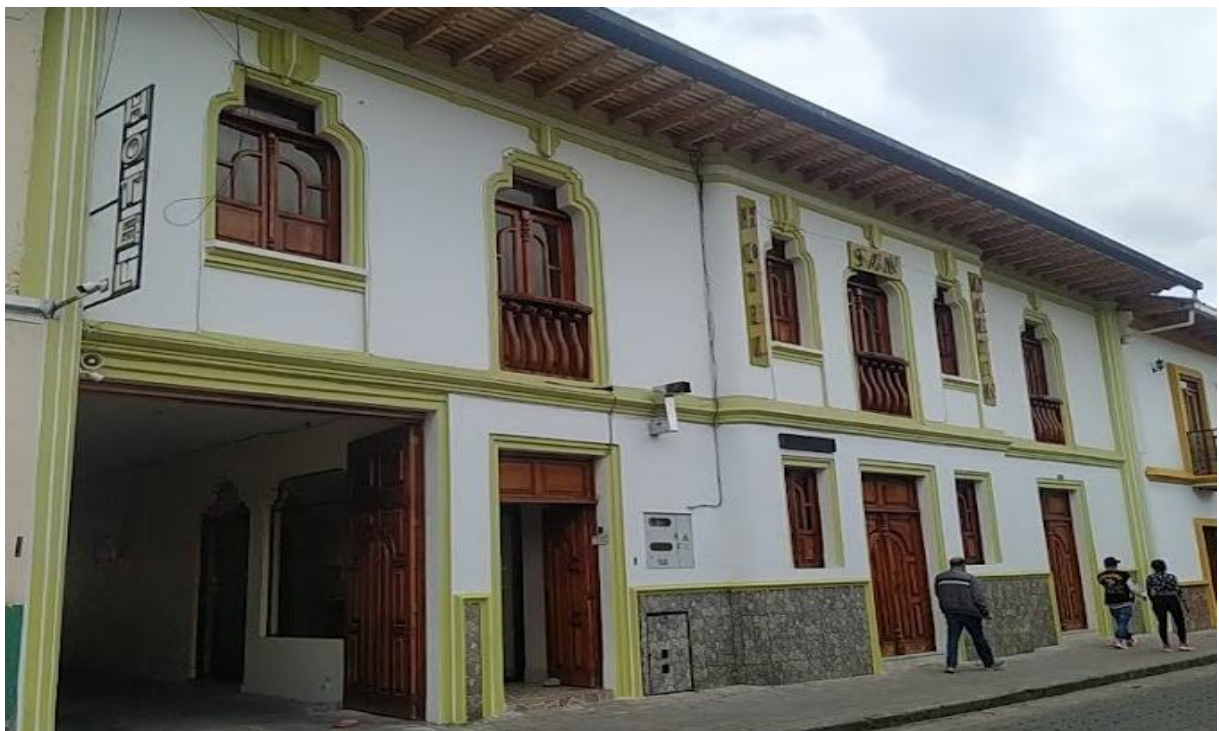
Figura 18. Fachada Hotel San Martín
