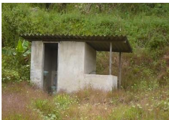
Figura 4. Instalación sanitaria PINDICAL.
