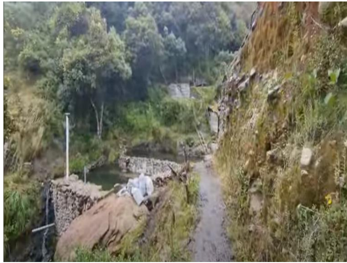
Figura 102. Estado del suelo
