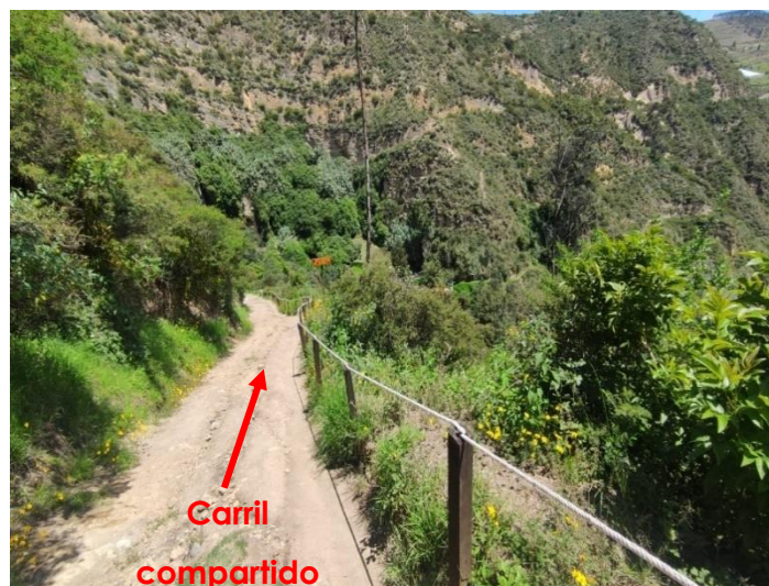
Figura 41. Infraestructura ciclística El tingo
