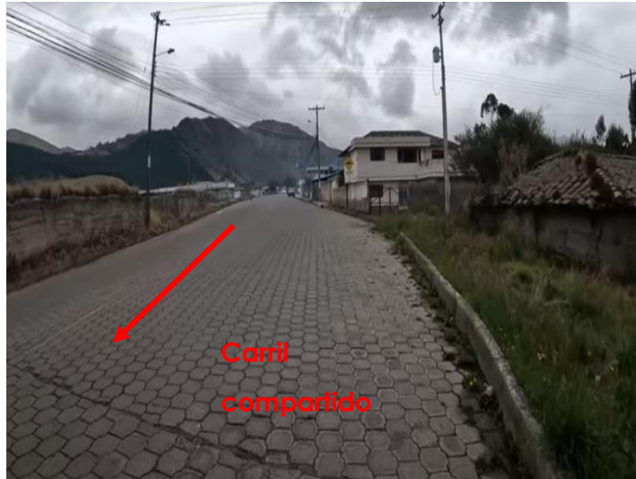
Figura 59. Infraestructura ciclística rio la chimba
