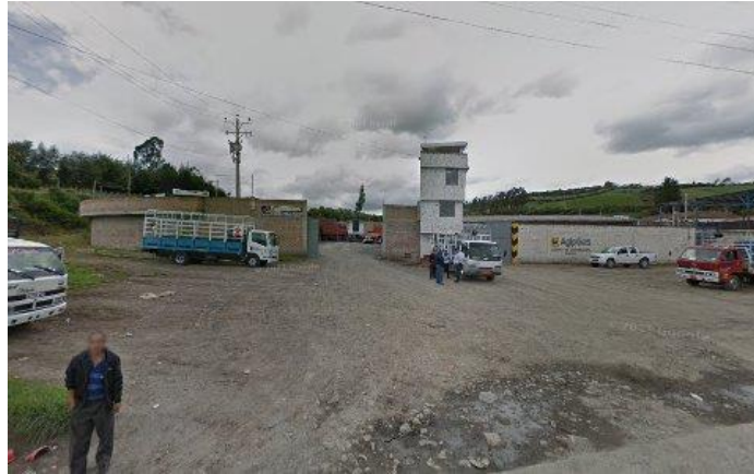
Figura 4: Centro de Acopio Realgas S.A.
