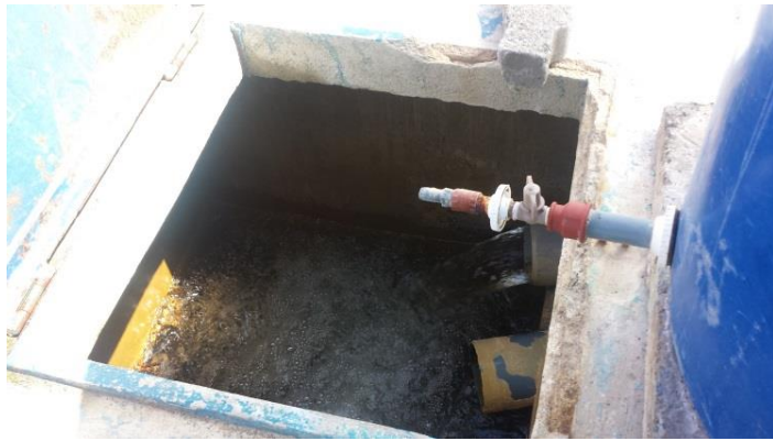
Sistema de cloración planta de tratamiento Yambá-09/06/2014
