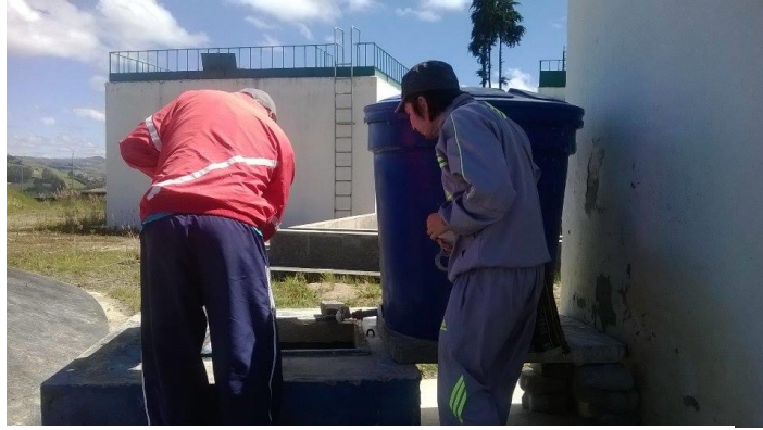
Sistema de cloración- Wilmer Quelal-09/06/2014
