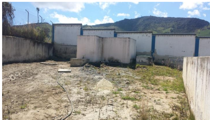
Tanque de captación Yambá-San Pedro de Huaca-09/06/2014
