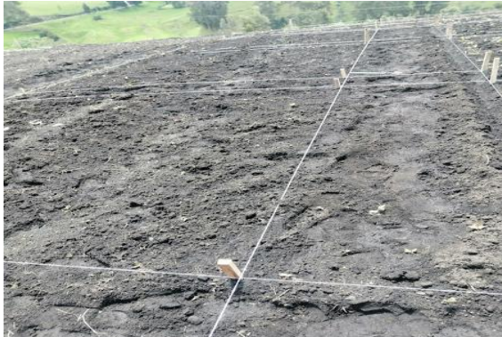
Figura 5. Delimitación y preparación del terreno.
