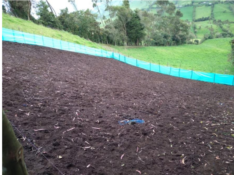
Figura 4: Preparación del suelo
