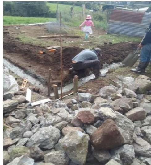
Figura 6. Construcción del galpón
