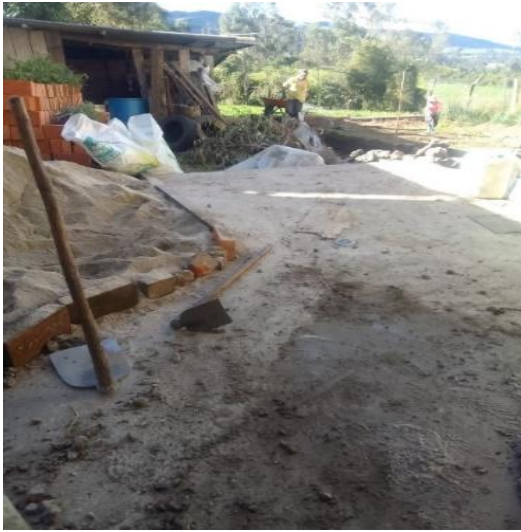
Figura 5. Materiales de construcción
