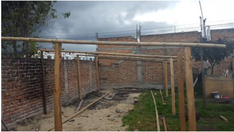
Anexo 1. Construcción del galpón
