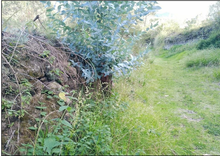
Figura 13. Muro de sostenimiento corte talud
