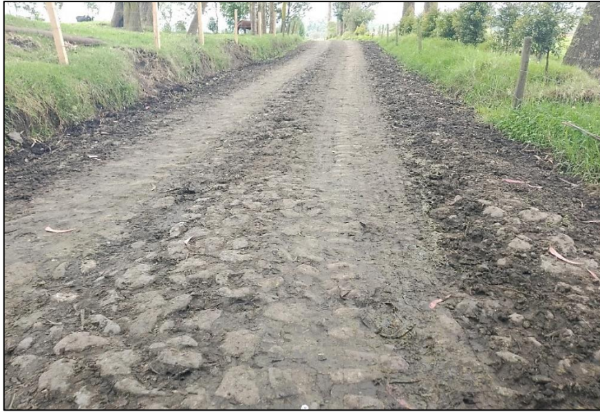
Figura 5. Calzada empedrada sector El Molino de San Luis
