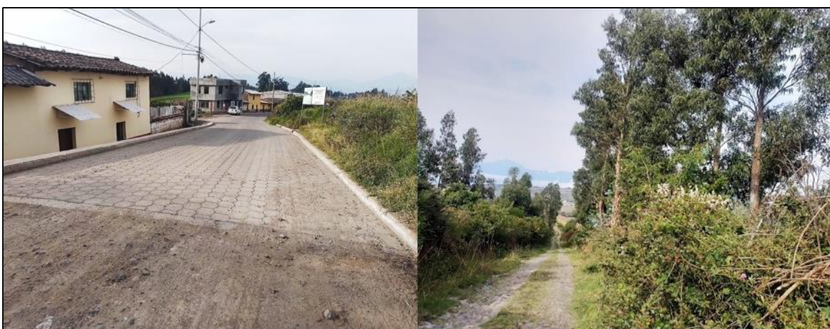
Figura 23. Estado actual del camino La Portada
