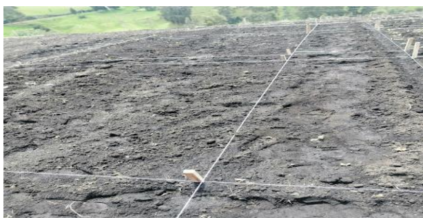
Figura 3. Delimitación y preparación del terreno.
