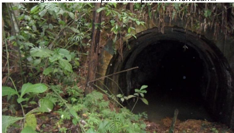
Fotografía 12: Túnel por donde pasaba el ferrocarril.
