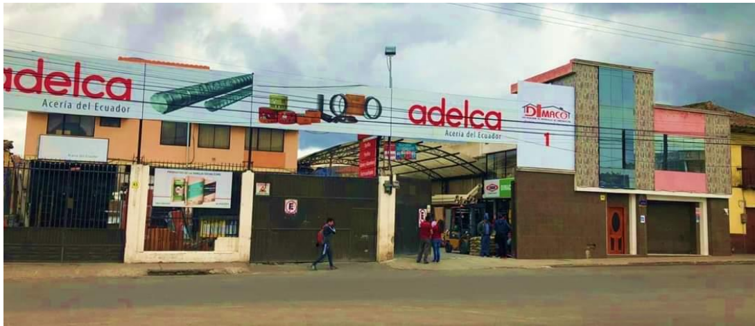
Fotografía 1. Vista frontal ferretería Dimaco. Fotografía tomada en febrero 2019.
