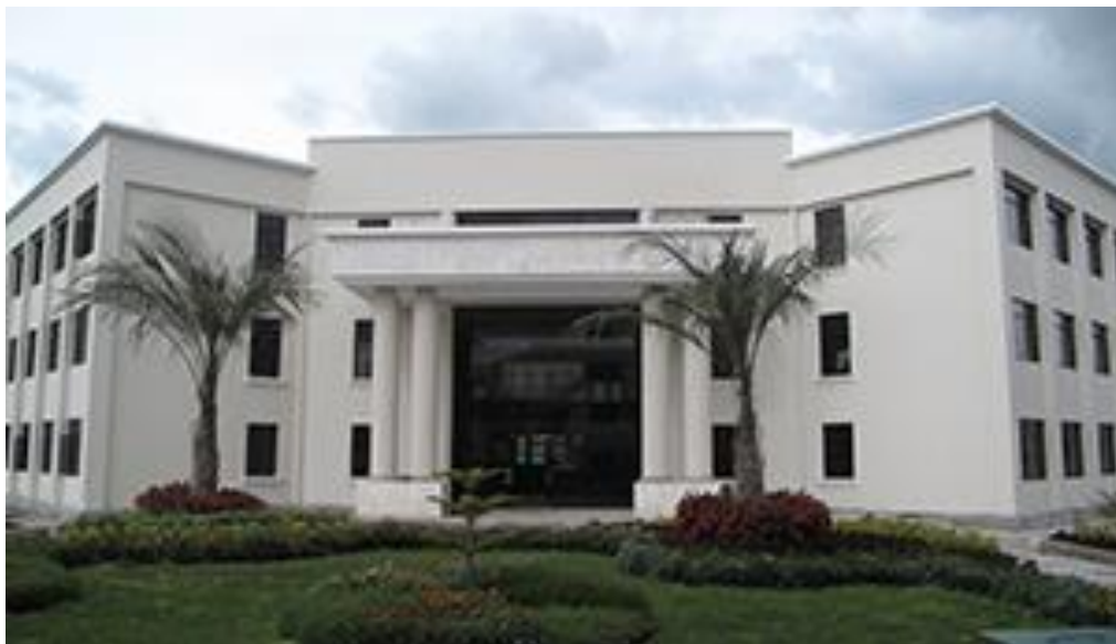
Figura 16. Edificio de Aulas
