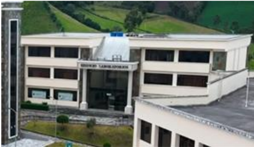
Figura 20. Edificio de laboratorios
