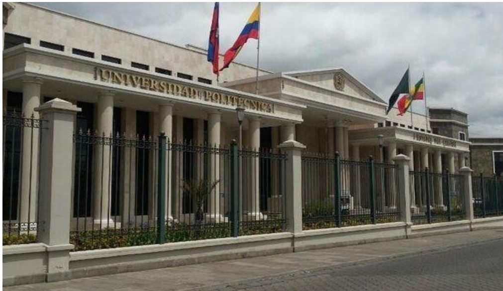
Figura 11. Edificio Principal de la Upec
