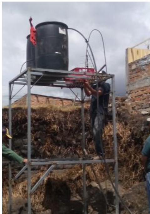
Foto 3: Instalación del sistema de riego
